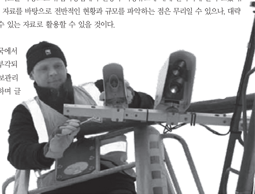
[그림 6] 시정계 설치 장면
