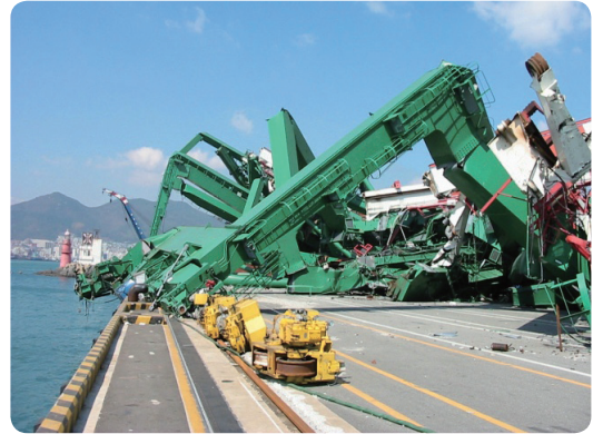
[그림 1] 부산항 신감만부두 크레인 붕괴
