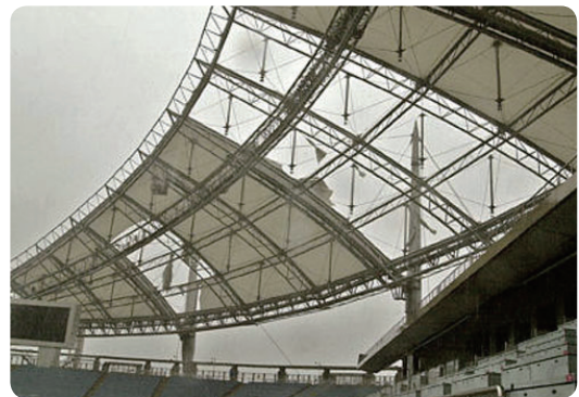
[그림 2] 서귀포 월드컵경기장 지붕 손상
