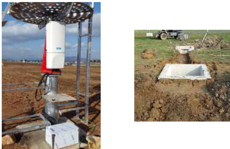
공항기상관측장비(AMOS) 설치 현장
