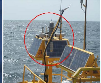
선박충돌에 의한 중량중속 센서 파손 모습
