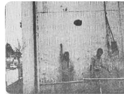
<울릉도항 쾌속선 터미널의 안벽에 남아있는 침수흔적/ 손끝에 물 흔적이 보임>
