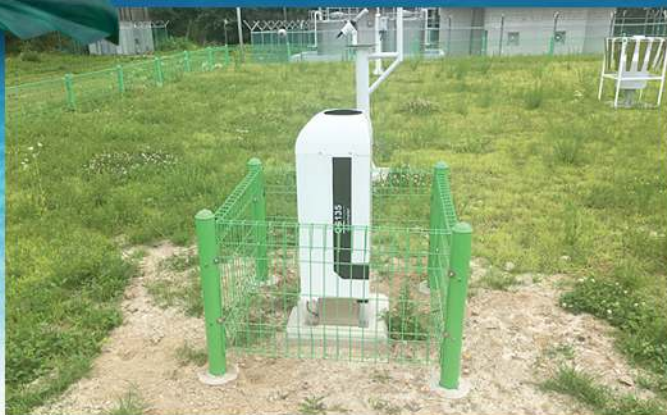
기상관측환경 개선공사 실시(6.8.~7.4.)
