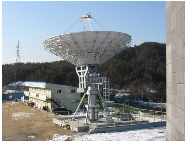
[그림 3-23] 반사판 인양 설치(좌), 안테나 구축 완료(우)
