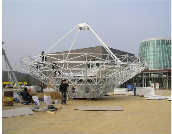
[그림 3-22] 안테나 조향 구동부 인양 설치(좌) 반사판 및 지지대 조립(우)
