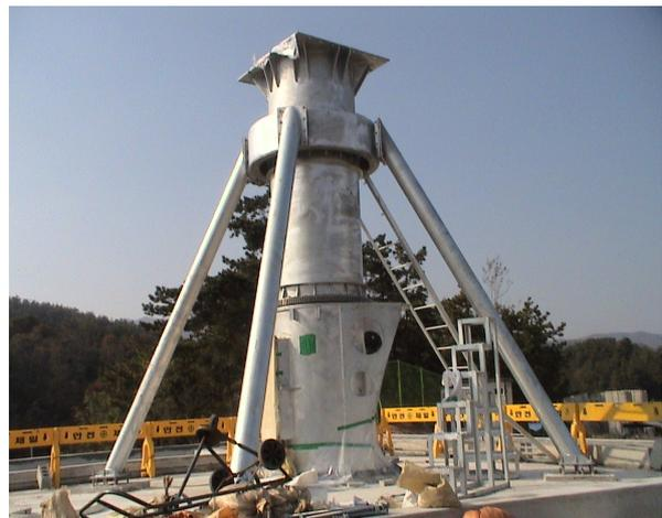
[그림 3-21] 안테나 기초대 설치(좌) 지지구조물 설치(우)
