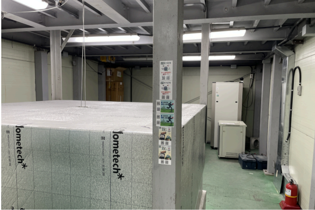
정선 다목적 지하심부 암반실험실 내부 소음차단막, 출처 = 직접 촬영
