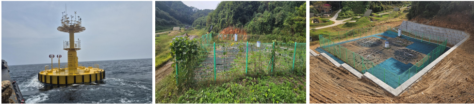
[그림 4-3] 서해중부바깥먼바다 10m 해양기상부이(좌), 파주 공중음파관측소 시설 보강 전, 후(중, 우)
