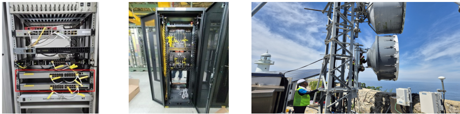
[그림 4-33] 마이크로웨이브 전산장비 설치(좌), 전용회선 구축(중), 안테나 설치(우)
