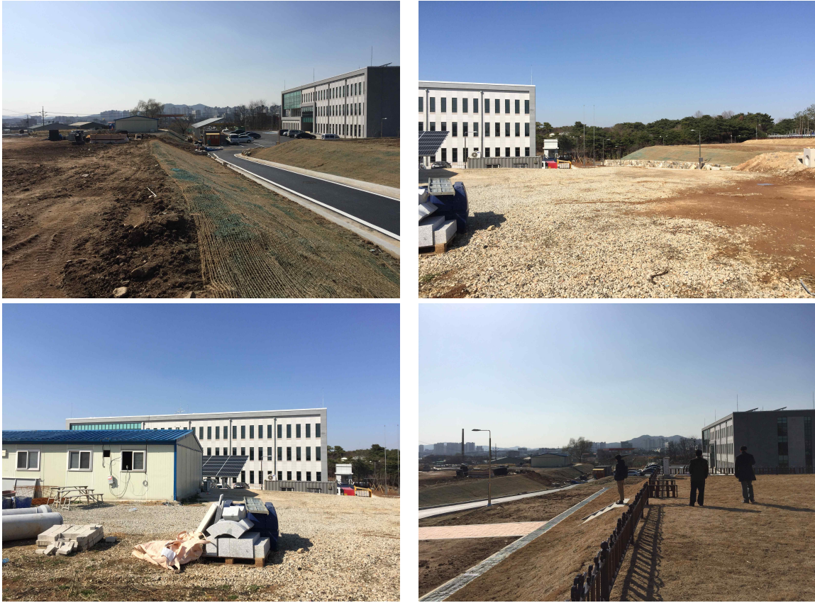
[그림 18] 기상·지진장비 인증센터 신축 부지 현장 사진
