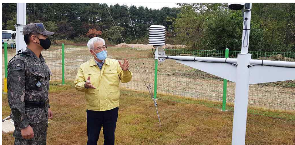
| 판문점 AWS 시설을 점검 중인 김종석 기상청장 |
